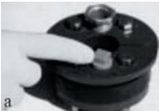
Determine que tipo de pozo tiene y como verter el blanqueador en el pozo. Algunos pozos tienen un sello sanitario con un aireador o un tapón que puede ser retirado (a). Si se trata de un pozo aburrado o perforado, se puede retirar toda la cubierta para proporcionar un espacio para verter el blanqueador en el pozo (b).
